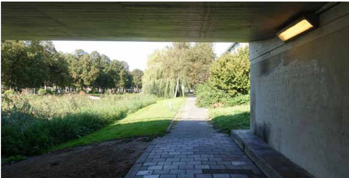
Onderdoorgang naar Sloterpas.
