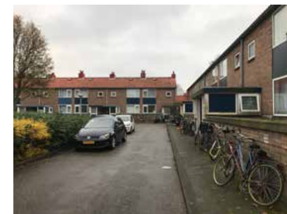
Hof bestaande situatie.
